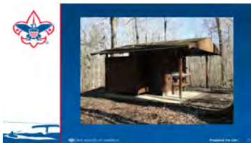
Pit latrine (D)
