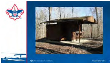
Pit latrine (D)
